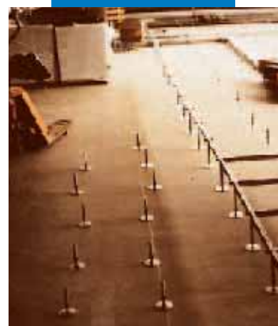
Lissage avec Ultraplan avant mise en oeuvre d'un plancher technique
