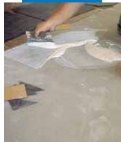
Exemple de pose de PVC sur ragréage Ultraplan - CD2 - Milan - Italie
