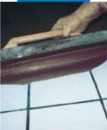
Application d'Ultraplan à la lisseuse sur carrelage existant avec application préalable de Mapeprim SP
