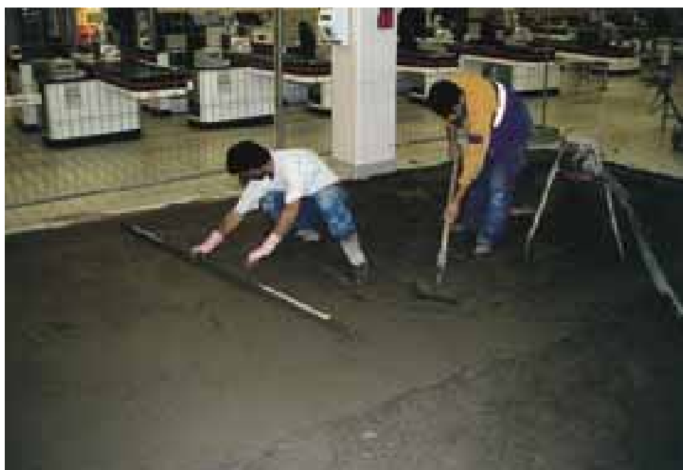
Réparation rapide d'une chape dans un supermarché
