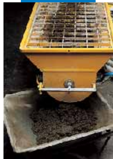
Malaxage de Mapecem avec un malaxeur horizontal
