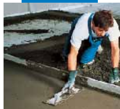
Finition par talochage du mélange Mapecem
