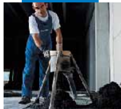
Alimentation du mélange Mapecem
