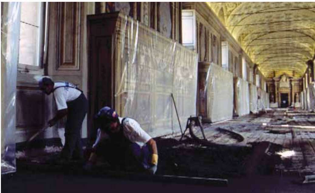
Application et finition de la chape Mapecem - Salons Sixtines - Cité du Vatican
