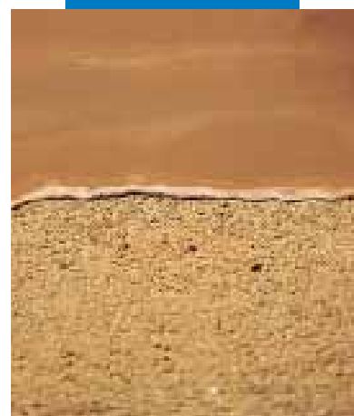
Finition de la chape Mapecem avec le ragréage autolissant Ultraplân
